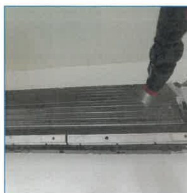
ภาพถ่ายที่ 2.2-23 การทำความสะอาดเครื่องปรับอากาศ
