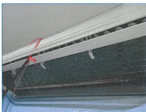
ภาพถ่ายที่ 2.2-23 การทำความสะอาดเครื่องปรับอากาศ
