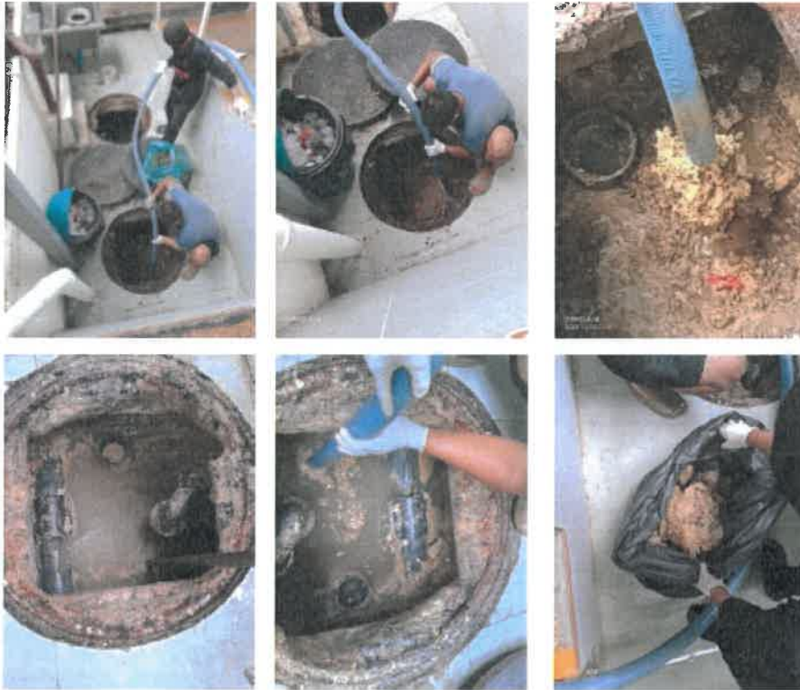
งานดูดบ่อไขมัน + บ่อเกรอะ (ในเดือนตุลาคม)
