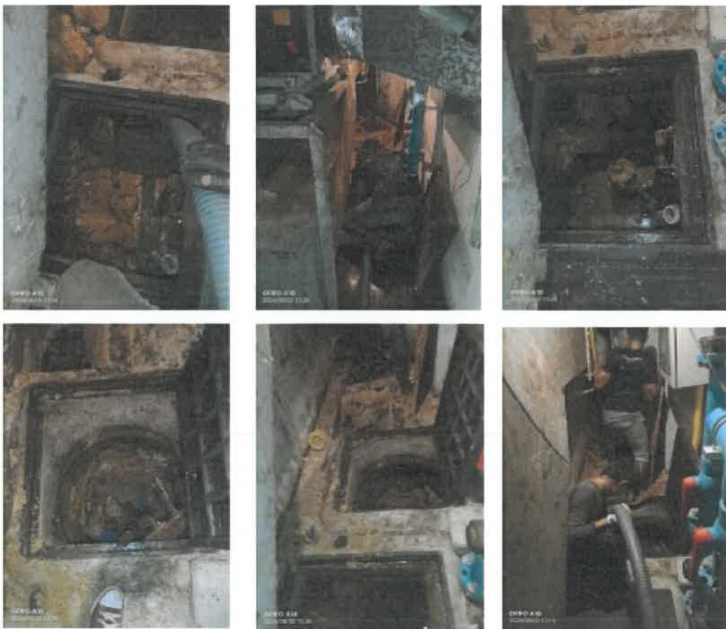
ภาพถ่ายที่ 2.2-12(2) การดูดกากตะกอน
